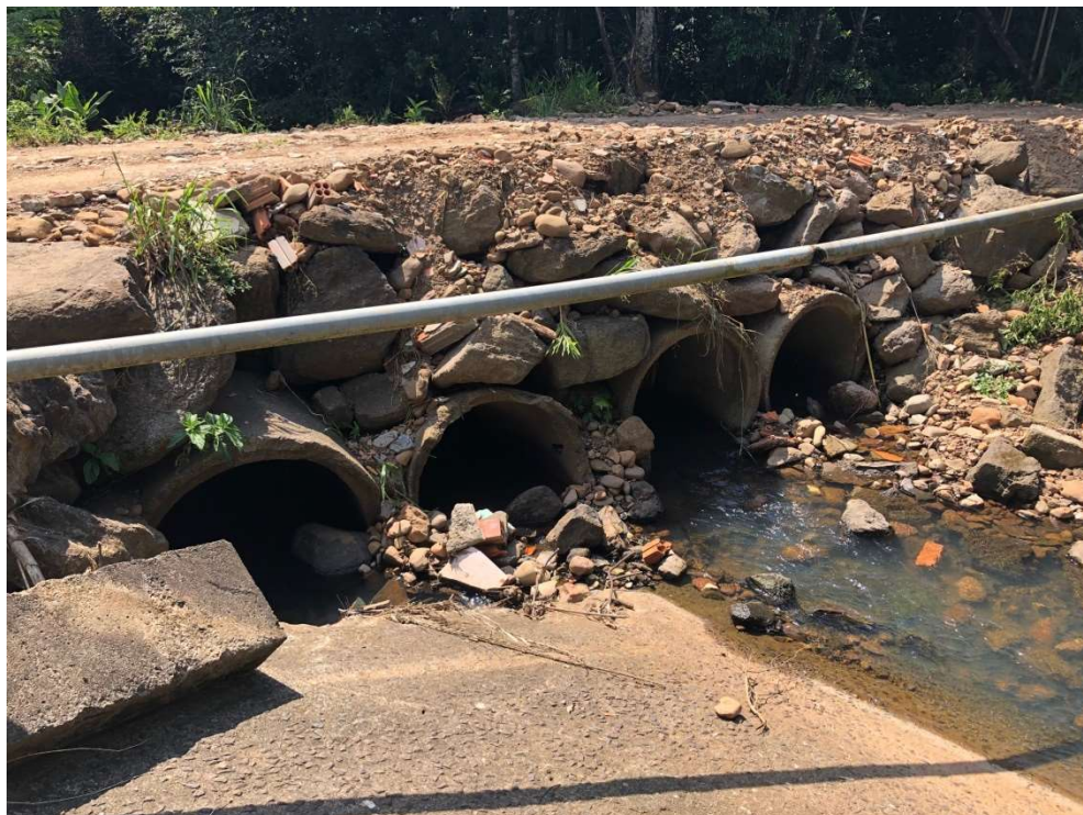
Figura 4 – Tubulação à montante obstruída
