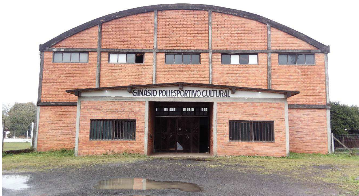
Figura 1 Estado atual do ginásio.
