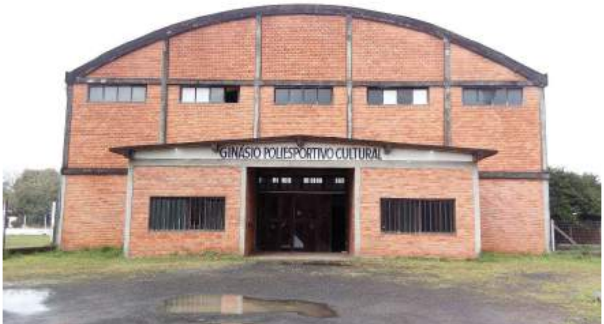
Figura 1 Estado atual do ginásio.
