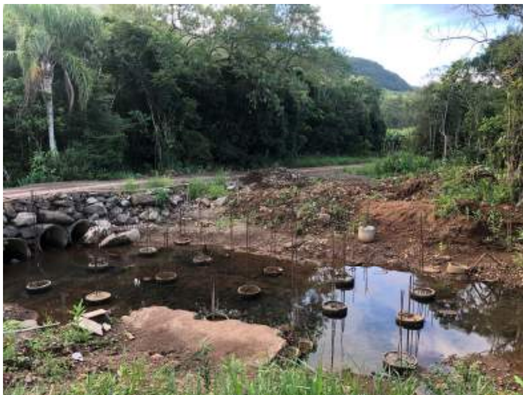
Figura 2 – Resíduos de concreto da antiga ponte parcialmente removidos
