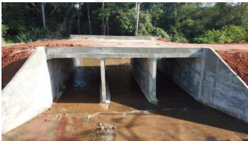
Figura 5 – Passagem molhada com galerias
