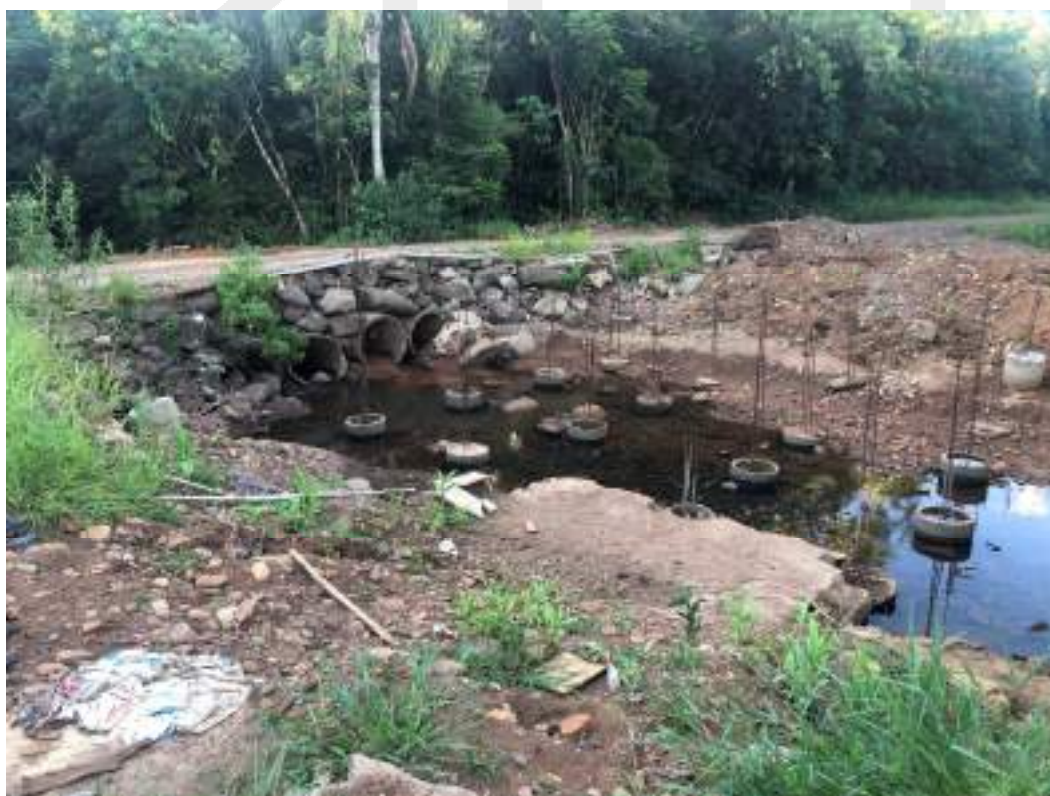
Figura 2 – Resíduos de concreto da antiga ponte parcialmente removidos
