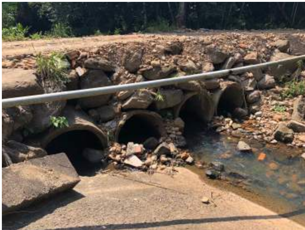
Figura 4 – Tubulação à montante obstruída
